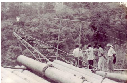
Jaringan Pipa Air di Lereng Merapi Tahun 1970
