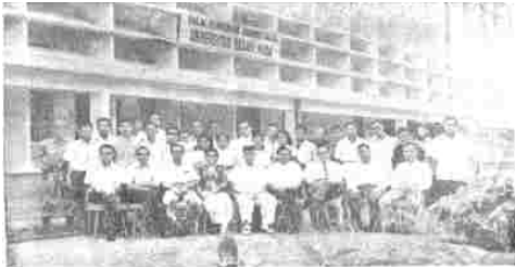
Gedung Balai Pembinaan Administrasi Sekip
