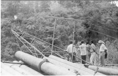
Pipa saluran berukuran besar dipersiapkan untuk diletakkan di atas landasan kerangka logam yang melindungi dua titik yang terpisah oleh jurang (1 Januari 1972)
