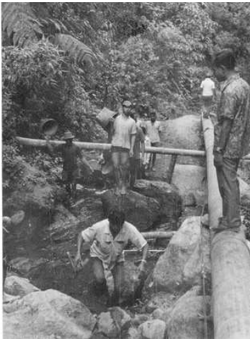
Pipa air yang sudah tersambung dengan landasan batu besar sebagai penopang yang merupakan hasil pemanfaatan lingkungan yang ada di lapangan (1 Januari 1972)
